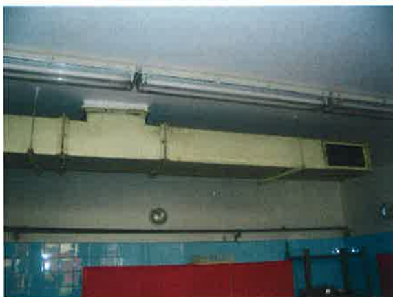
Odtah VZT v kuchyni
